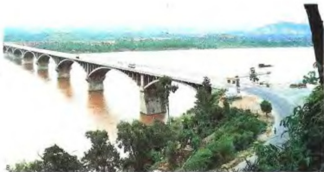
1990年建成的广西最长的梧州西江大桥。
