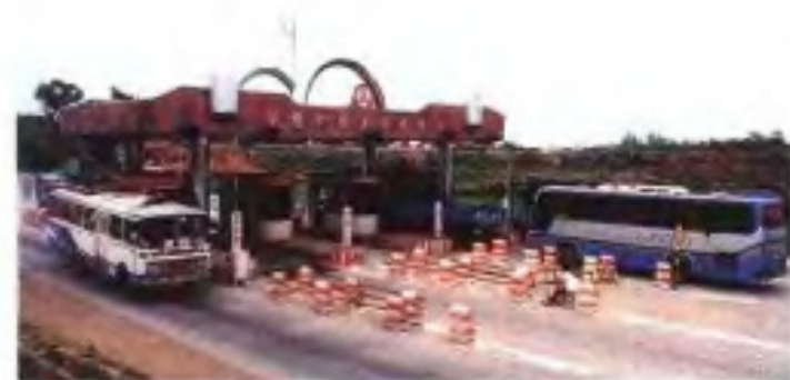
南梧公路五塘收费站。
