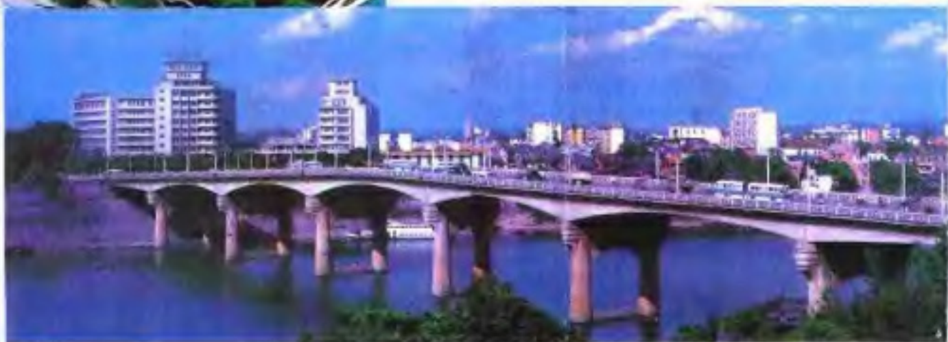
南宁邕江大桥。
