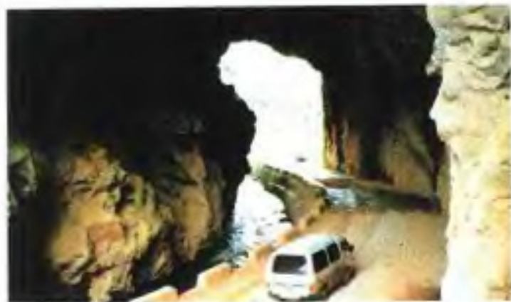
照阳关天然公路隧道。
