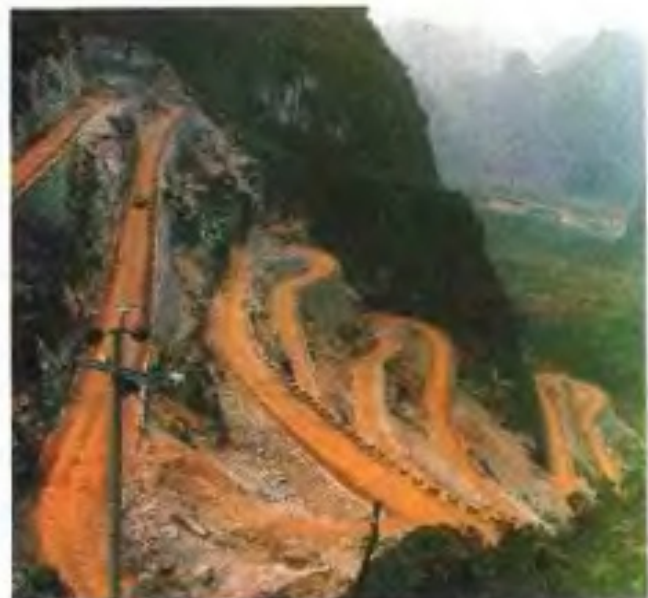
环江毛南族自治县以工代赈修筑的山区公路。
