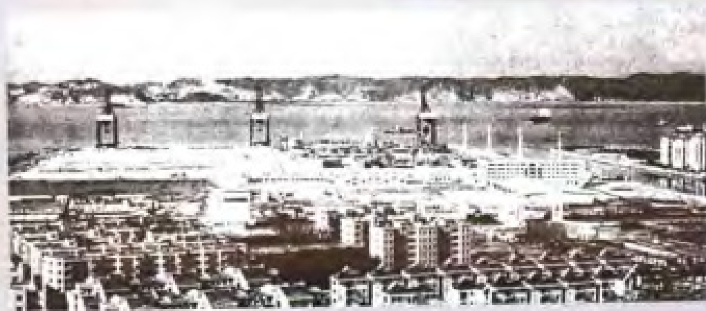
与香港国际货柜码头有限公司(HIT)合资建设的汕头国际集装箱码头于1998年全面竣工投产。
