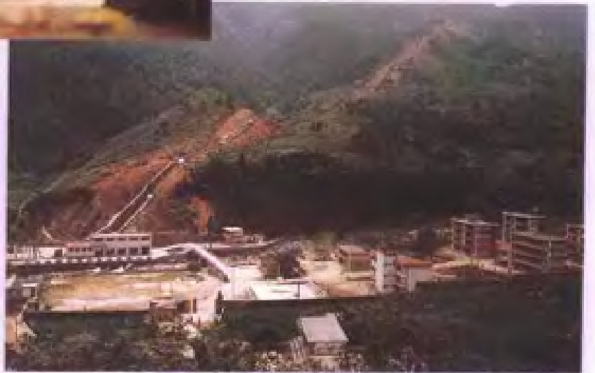
连南板洞水库 ▶ 第一级发电站
