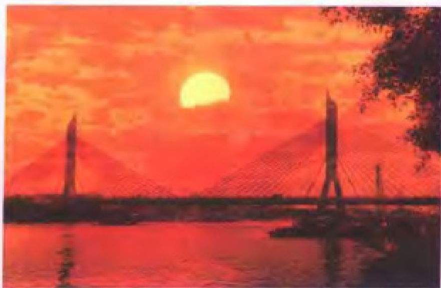
▲ 广州海印大桥横跨珠江，是中国第一座双塔单索面混凝土斜拉桥，建成于1988年，1992年获中国建筑工程最高奖“鲁班奖”。
