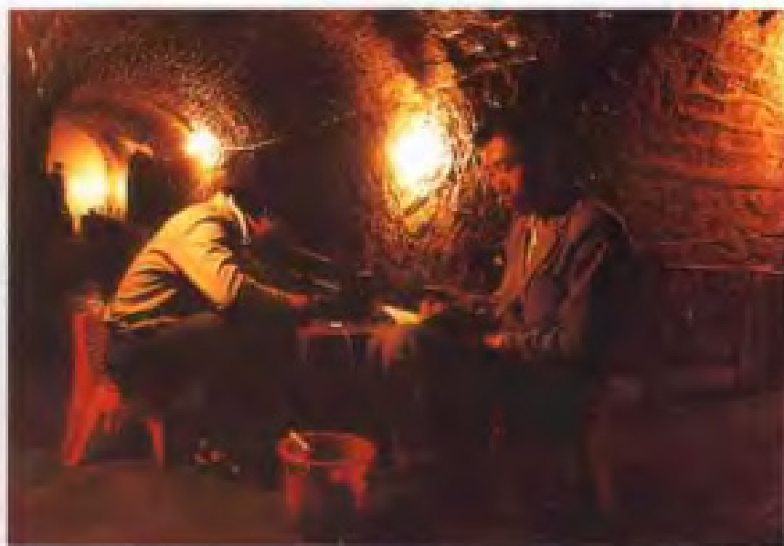
潮州隧道水管倾斜仪观测。
