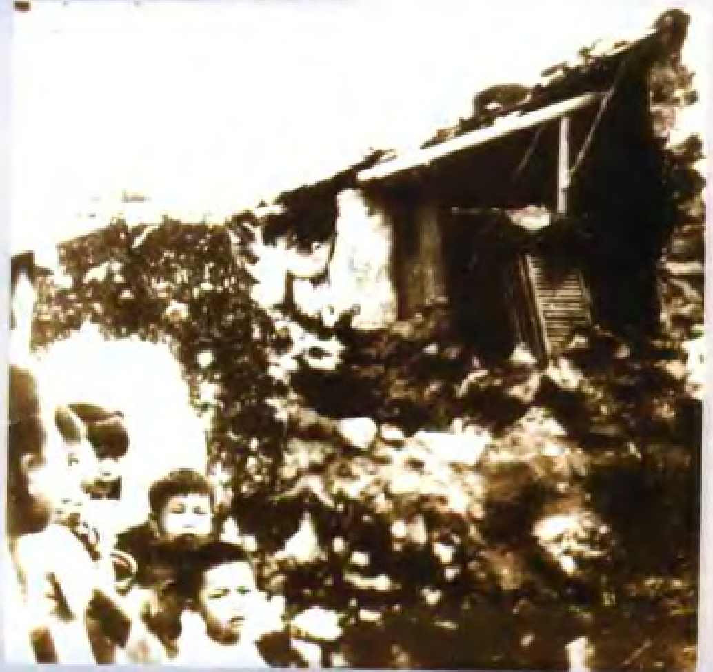
1969年7月 26日,阳江6.4级 地震民房倒塌。
