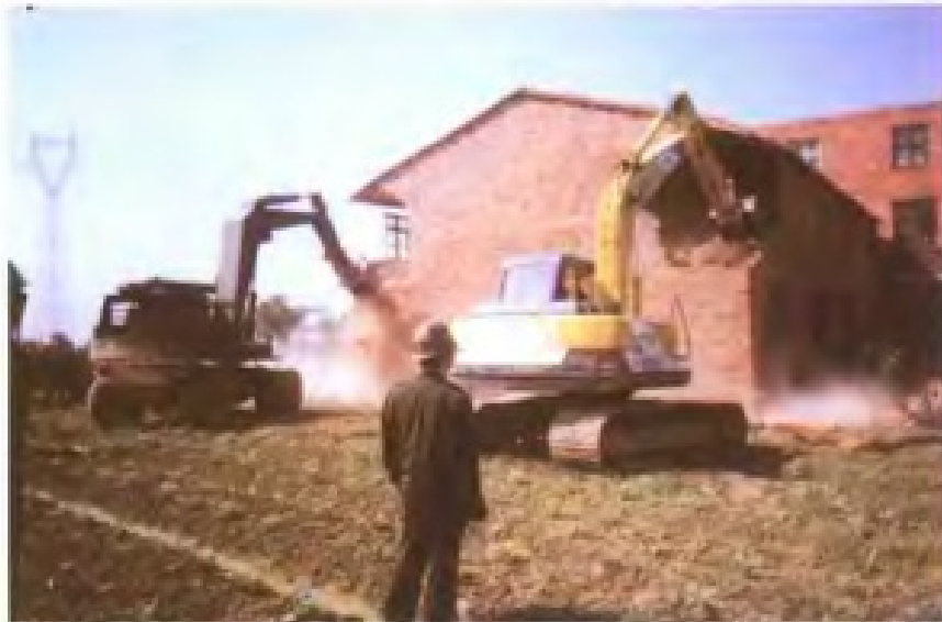
强制拆除违法建筑
