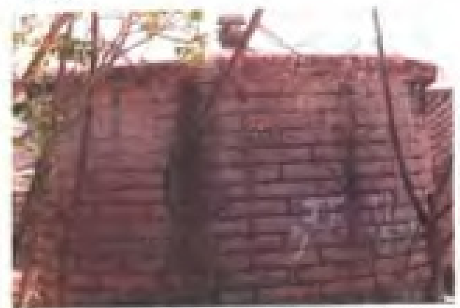
1958年建成的旧镇粮站石砌油池。
