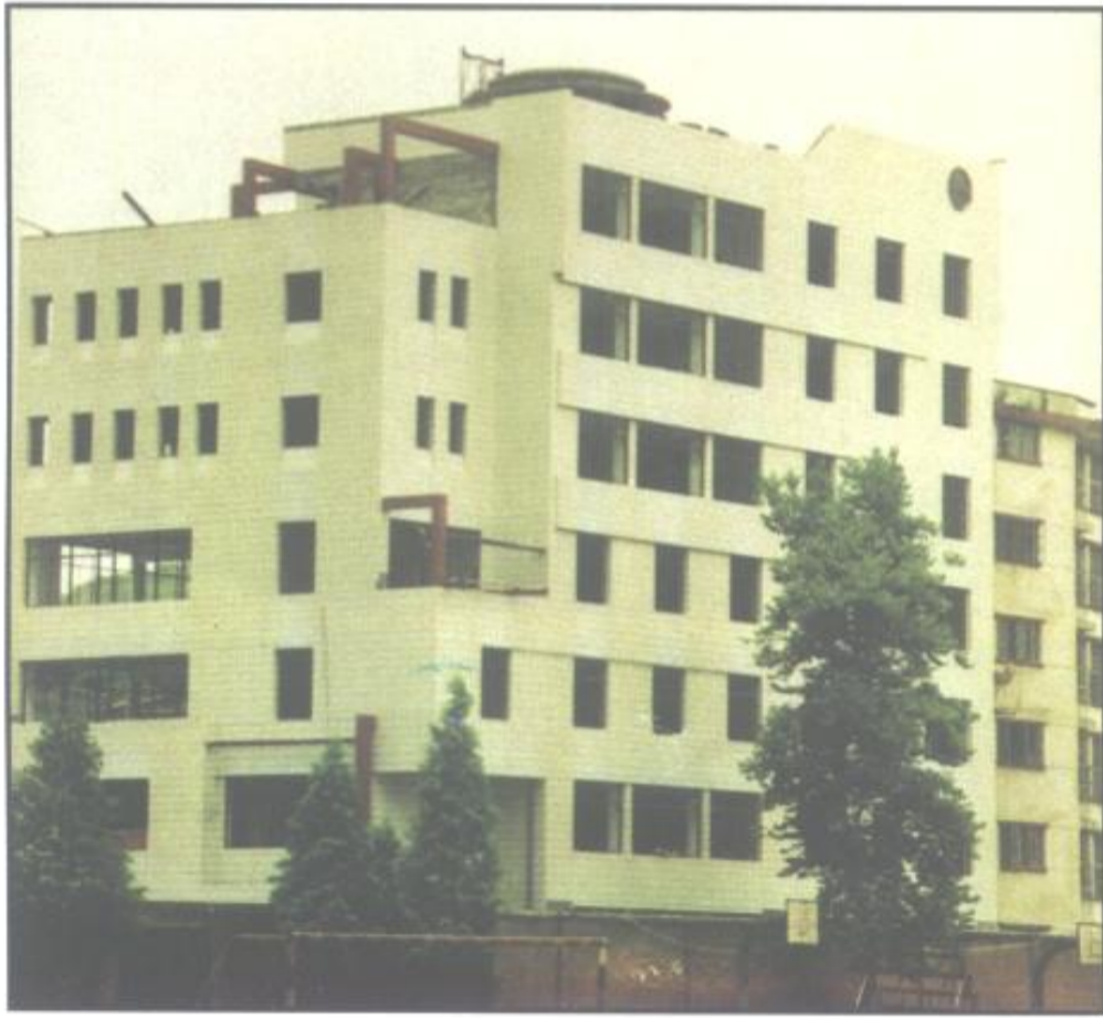
● 邵武一中教学试验楼
