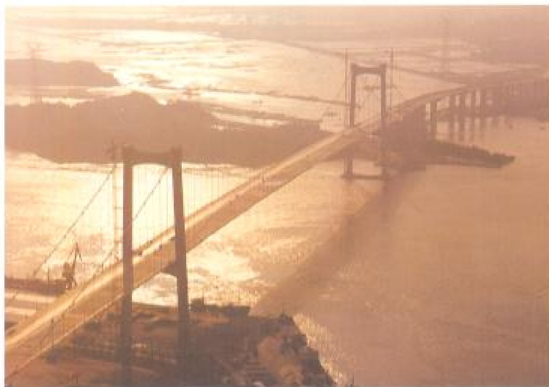
海沧大桥 (林世泽 摄影)
