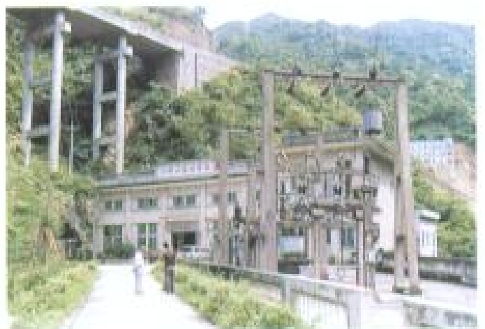
小坪二级水电站 (台桦 摄影)
