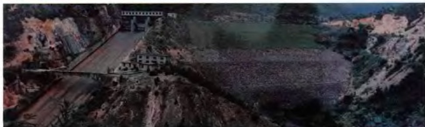
▼ 笋塔水库大坝
