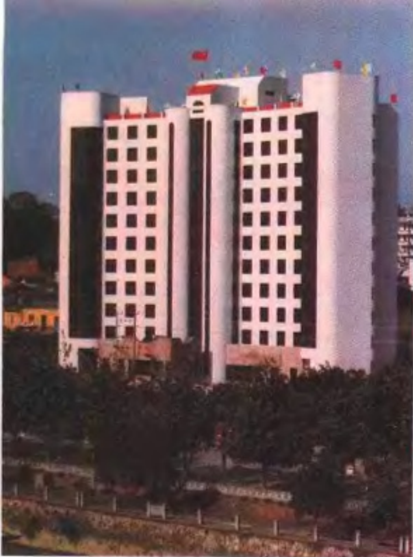
市人民政府大楼
