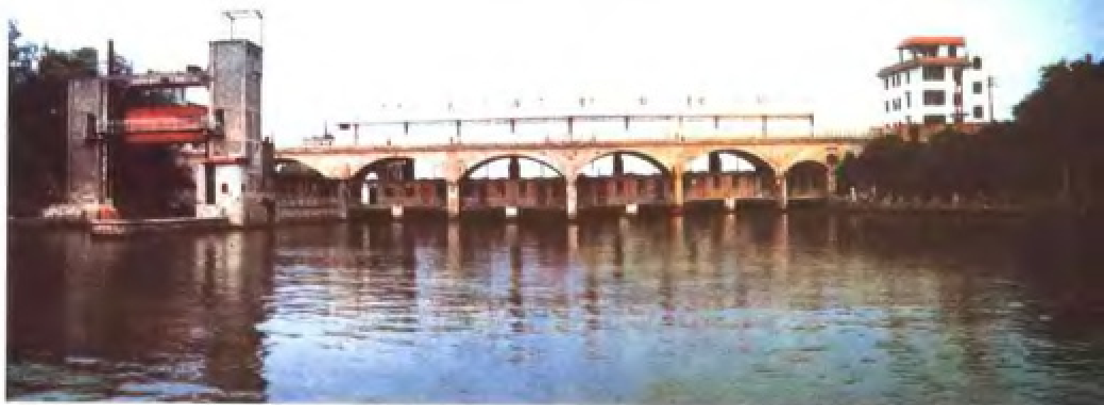
罗源松山围垦工程30孔挡潮排涝闸
