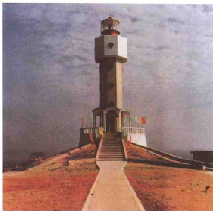
福建第一座现代化 导航灯塔——平潭 岛牛山灯塔
