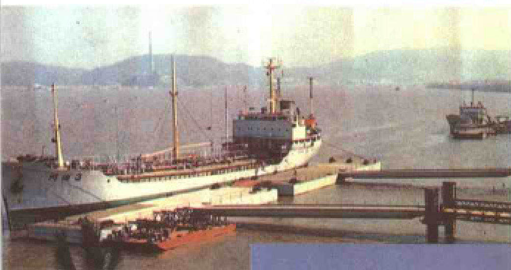
3000吨级沿海快速搭设 浮码头
