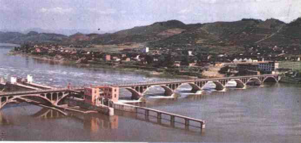
闽江复航第一闸——顺 昌洋口船闸
