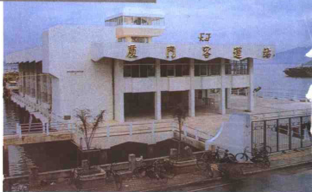
厦门内河客运站
