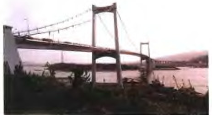
厦门海沧大桥
