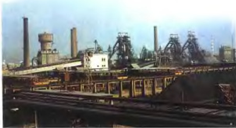
三明钢铁厂一角
