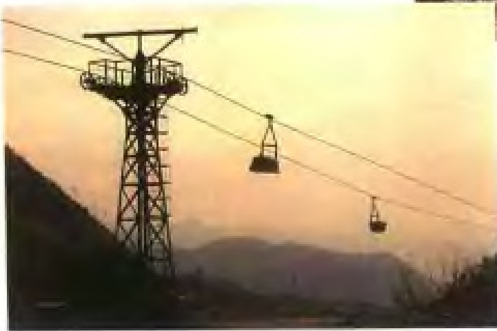
福建省潘洛铁矿潘田矿区运矿索道
