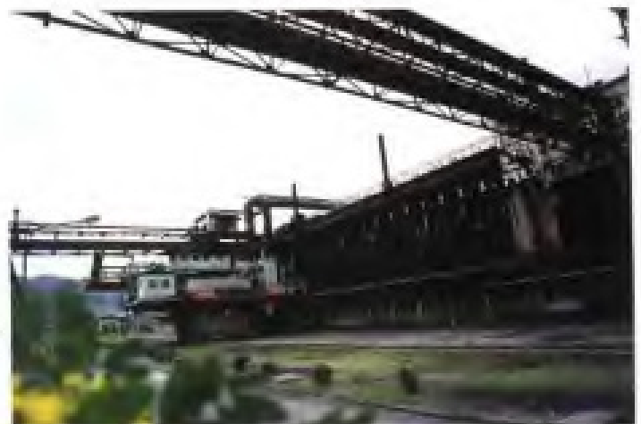
三明钢铁厂JN43-80型65孔焦炉外景
