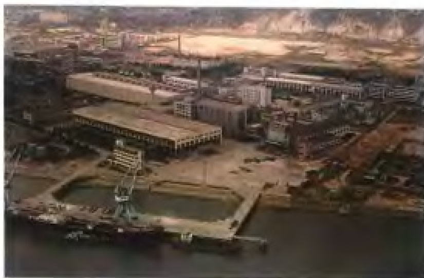
中国国际钢铁制品有限公司全景
