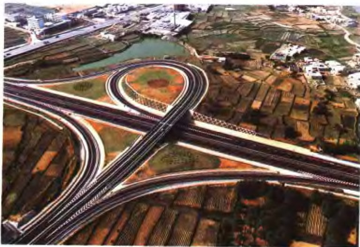
福厦高速公路
