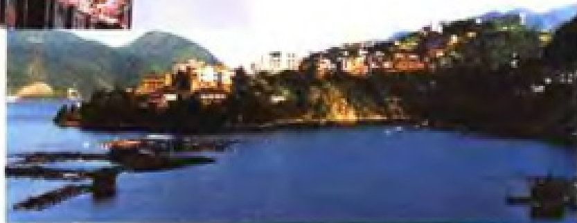
征地拆迁移民安置点
