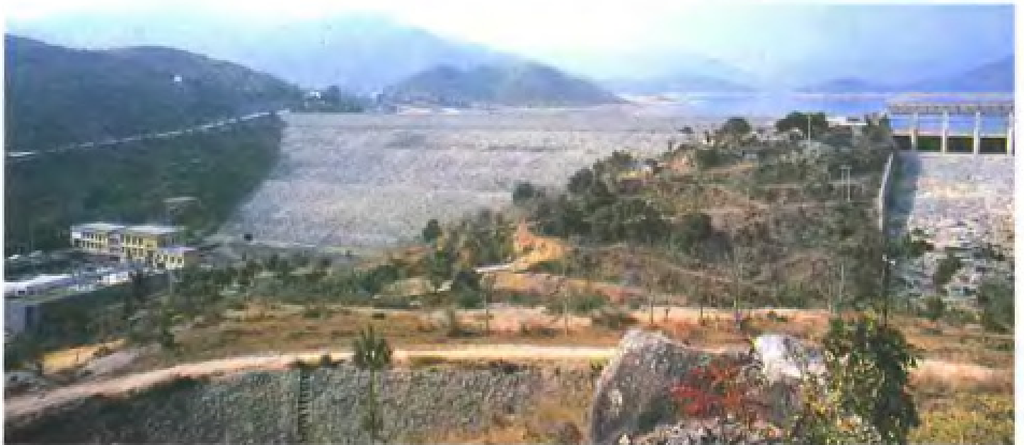
莆田东圳水库土石混合坝
