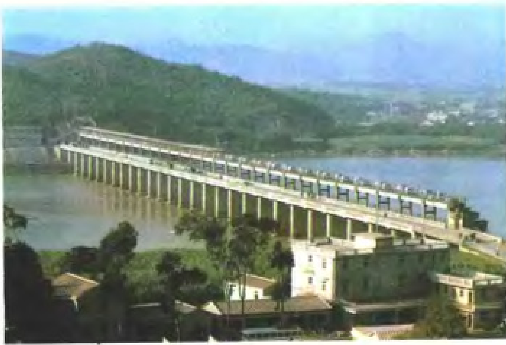
晋江金鸡拦河闸
