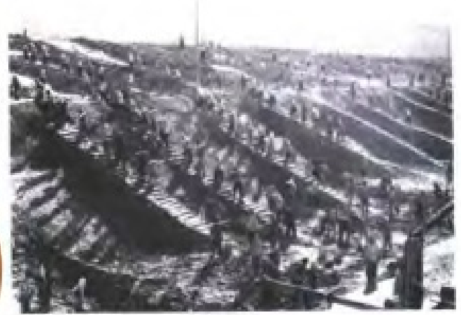
60年代, 山美水库工地场面
