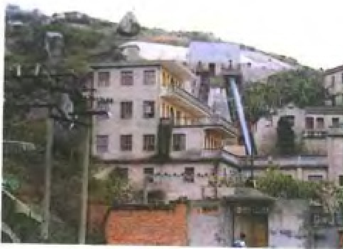
利用跌水发电的长乐三溪水电站
