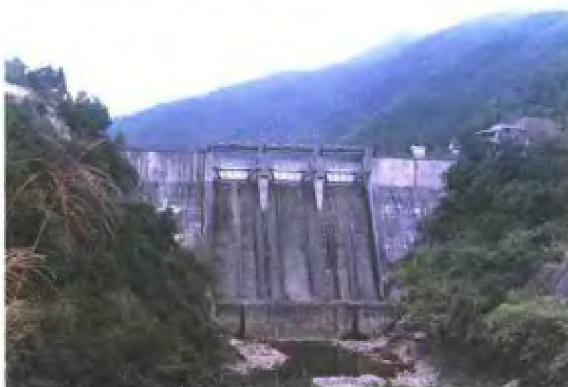
松溪茶州水库砌石空腹重力坝
