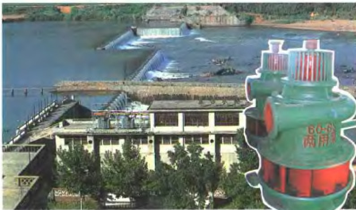
建瓯叶坊水轮泵站
