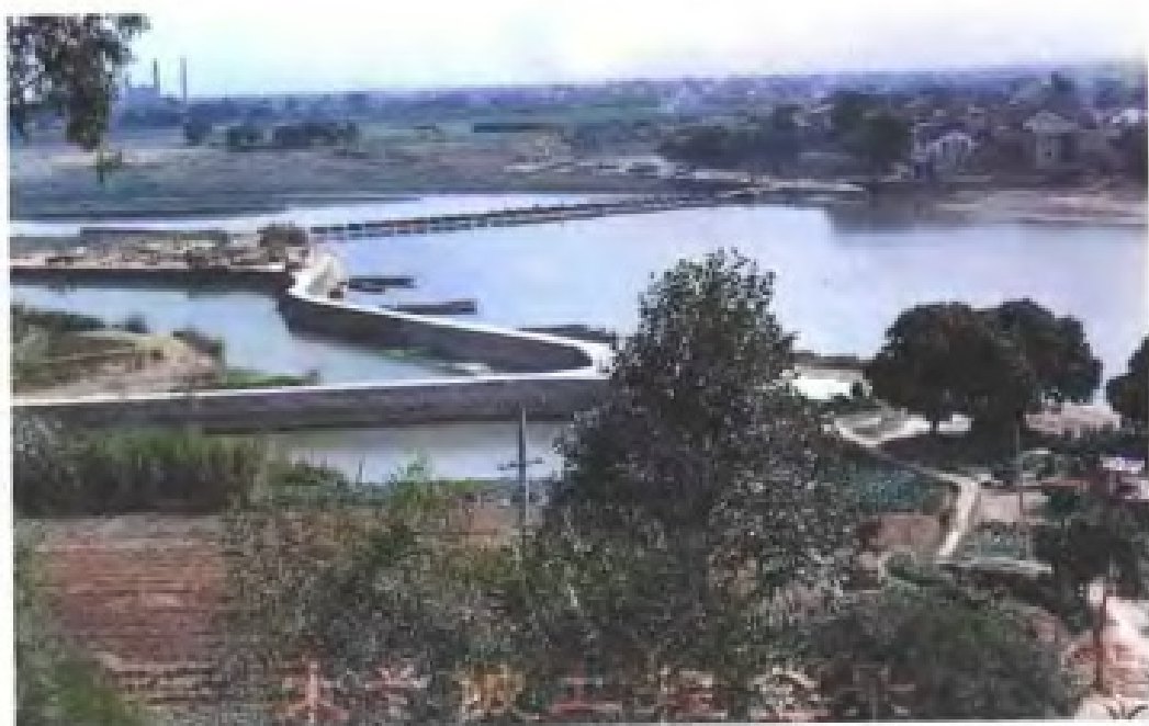
莆田木兰陂古代引水工程全景
