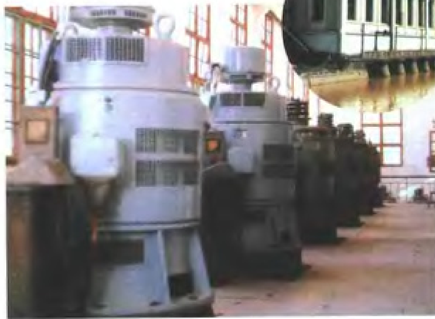
漳州天宝水电站·级抽水站
