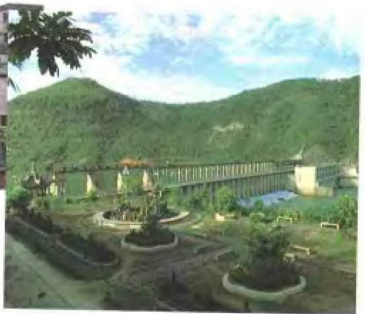
永安市鸭姆潭水电站
