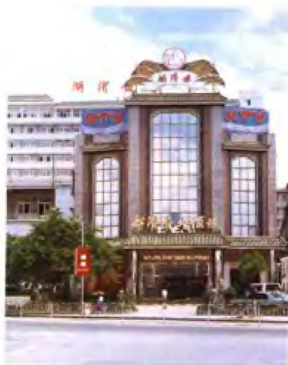
厦门市商业系统“好清香”大酒楼
