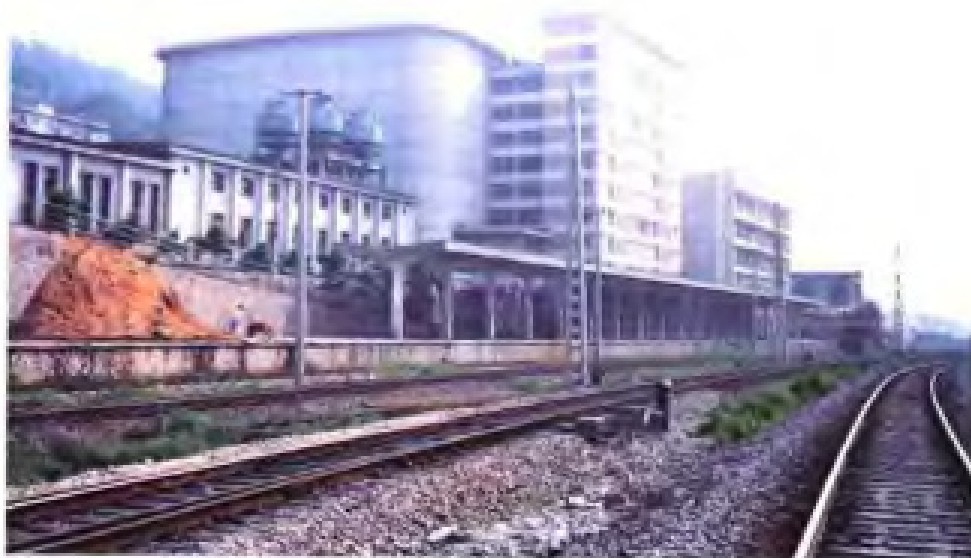
三明市肉联厂冷库及铁路专用线
