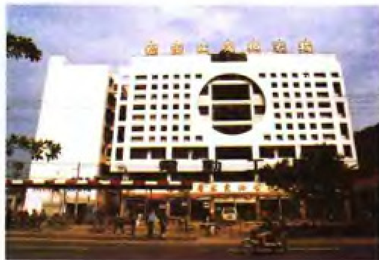
福建五交化公司大楼
