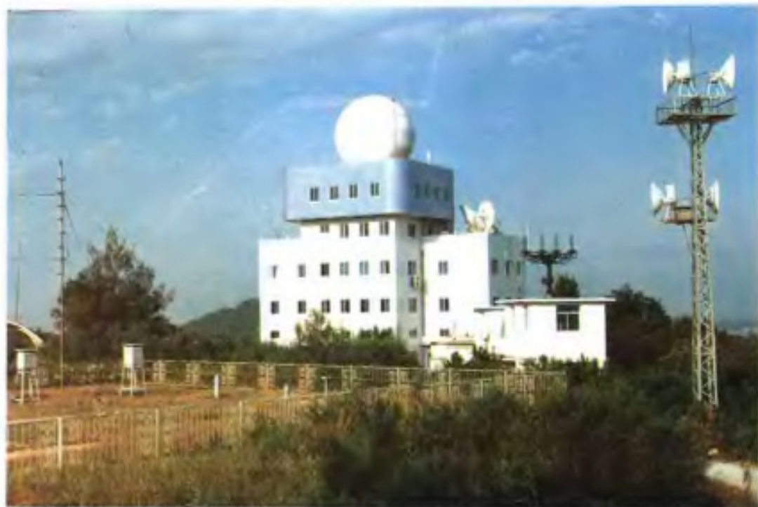
△国产S波段多普勒天气雷达在厦门市气象局投入业务运行
