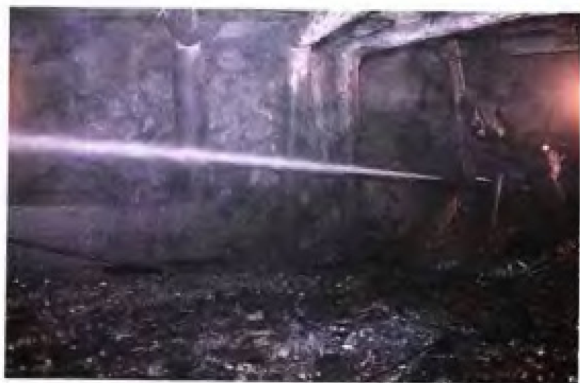
△邵武煤矿水力采煤工作面
