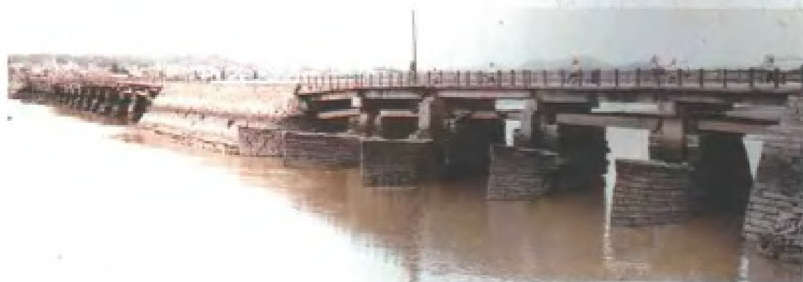
晋江安平桥(又名五里桥)全景,建成于宋绍兴二十一年(1151年)
