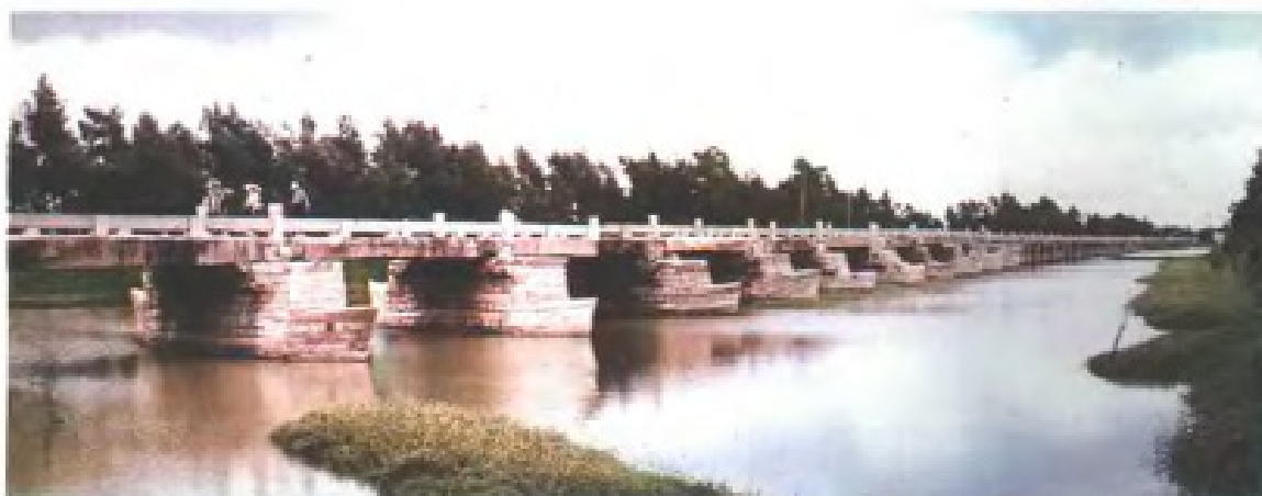
泉州洛阳桥(又名万安桥)全景,建于宋皇祐五年到嘉祐四年(1053~1059年)
