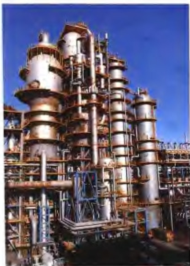
福建炼油厂催化裂化装置
