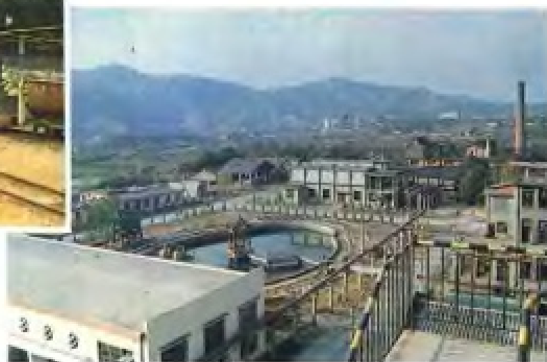
建瓯化工厂厂前区
