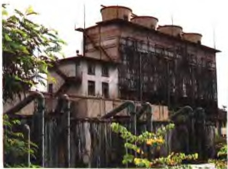
三明化工总厂污水处理装置
