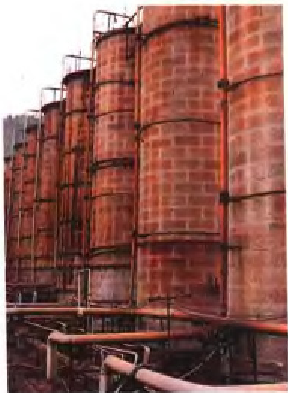
邵武化肥厂硝酸车间一角
