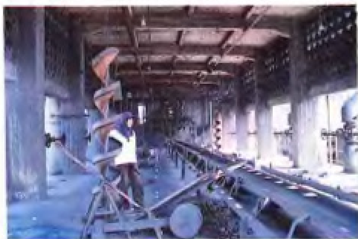
永春化肥厂石灰碳化煤球生产线
