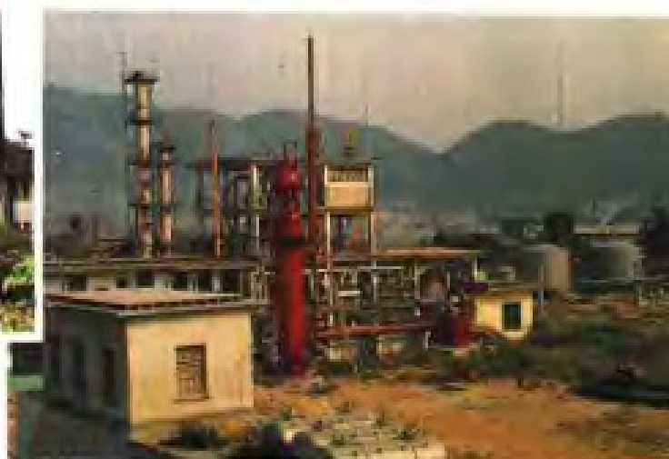
三明化工总厂甲醛生产装置
