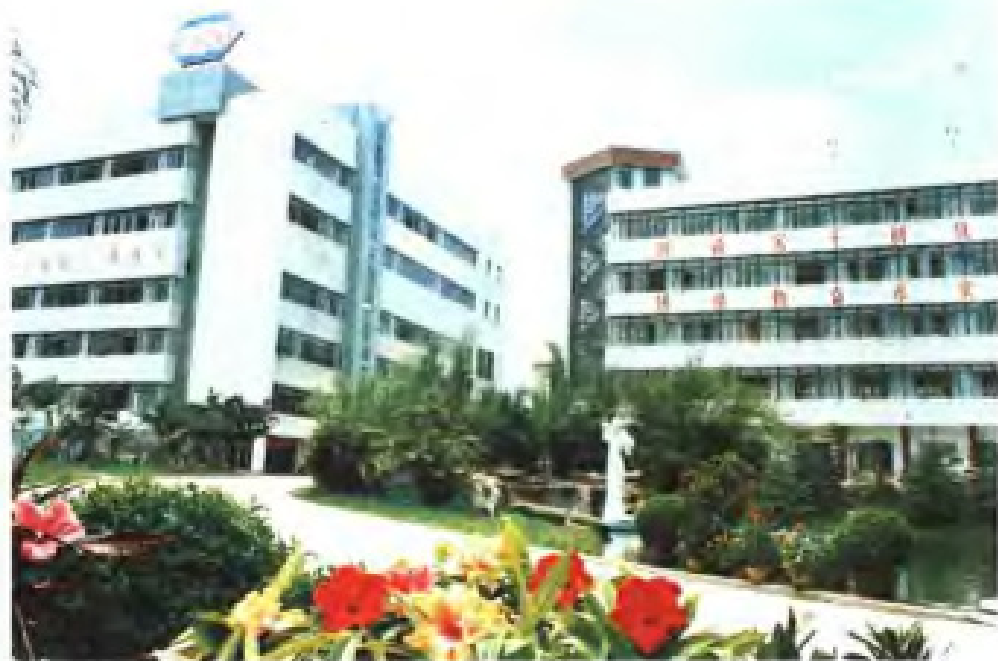
► 厦门华纶化纤有限公司
