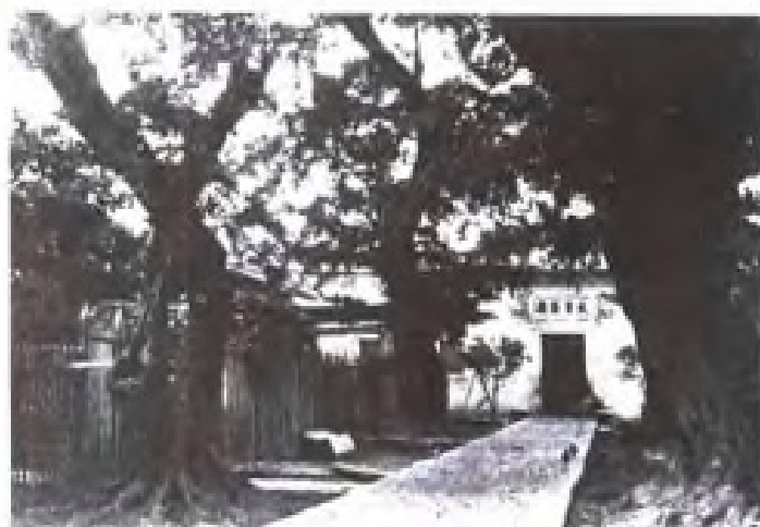
建于明代经清代修建的福州琉球馆
