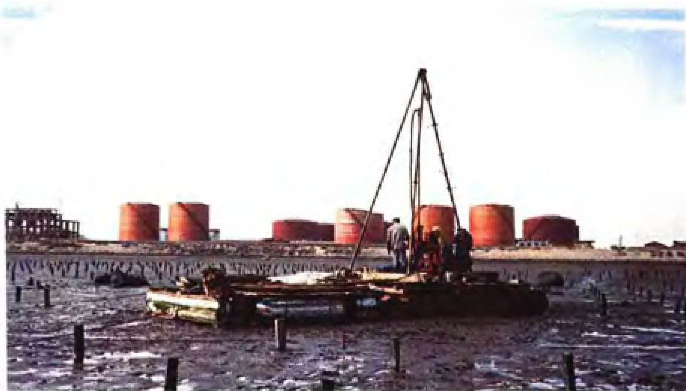
△省地质工程勘察院在福建炼油厂30万吨乙烯选址场地进行工程勘察
