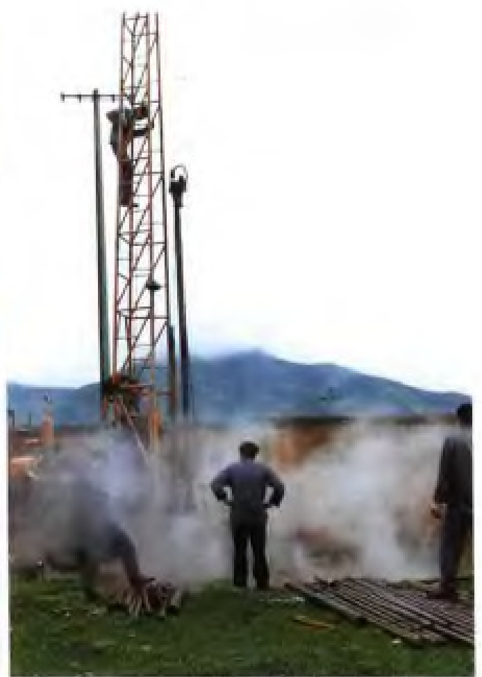
水压致裂试验
