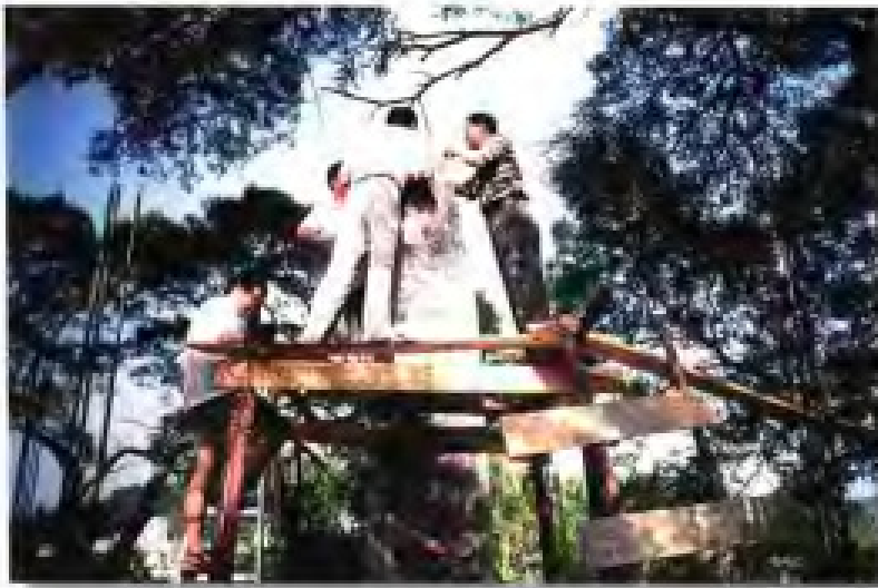
安装GPS观测点中心装置
