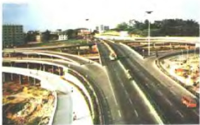
厦门厦鼓立交桥
