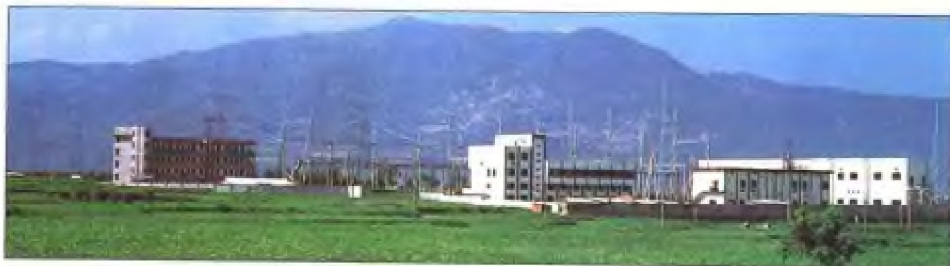
塘西 22 万伏变电站
