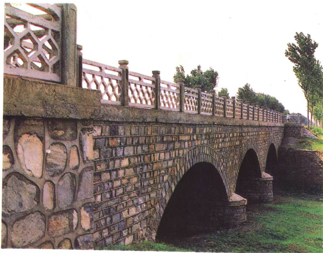
唐兴线新店子北石拱桥
