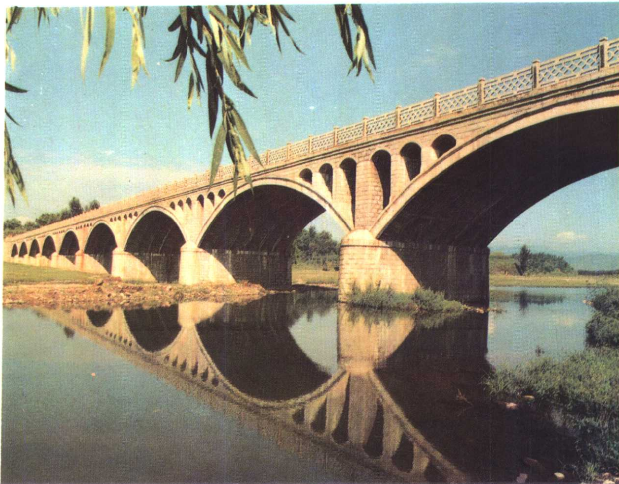
魏进河双曲拱大桥
