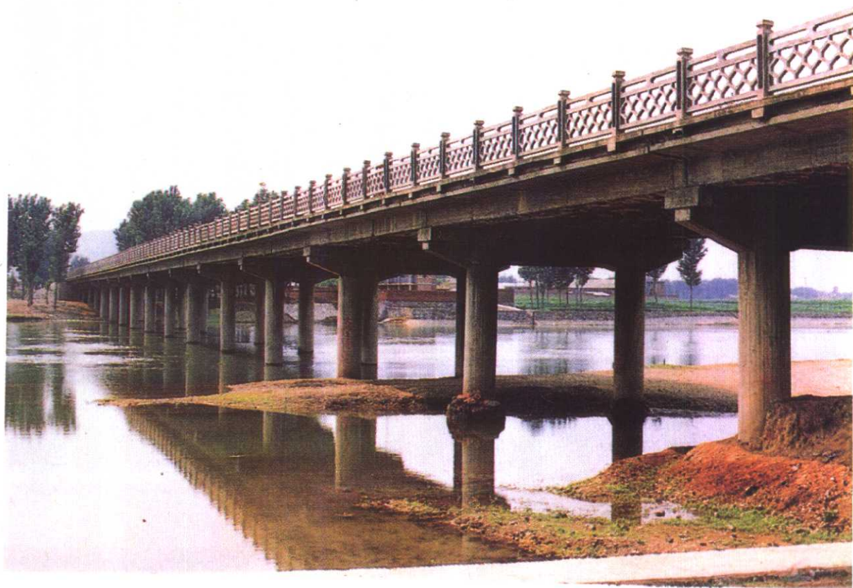
唐兴公路黎河大桥
