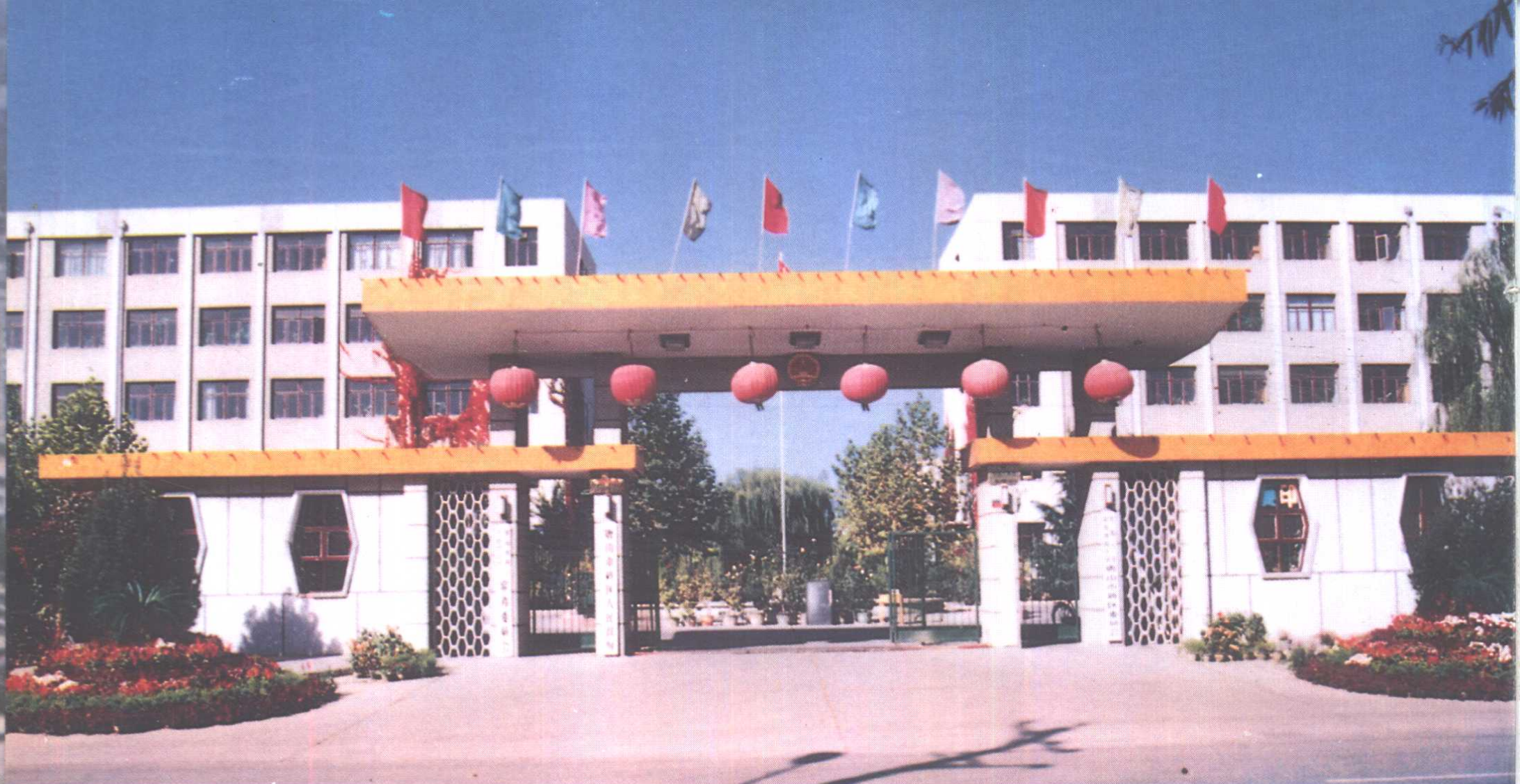
区委区政府机关大楼
