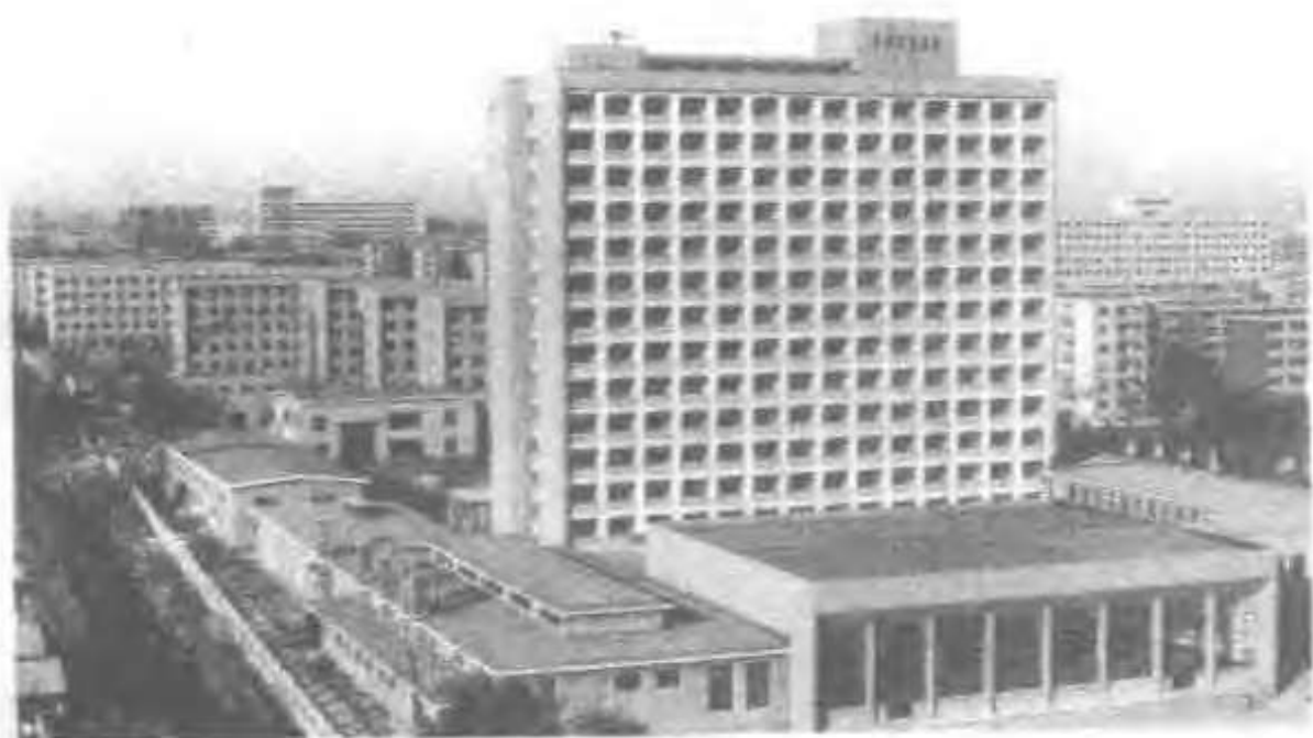
唐山饭店大楼
