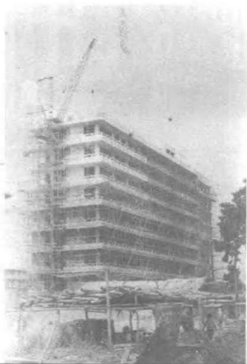
○建设中的妇幼保健医院大楼
