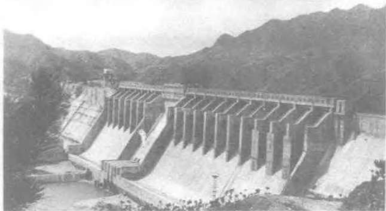
○潘家口水库大坝
