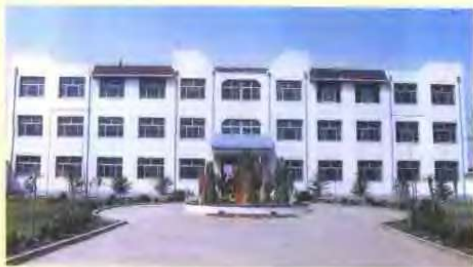
1997年，新落成的盲聋哑学校教学楼
