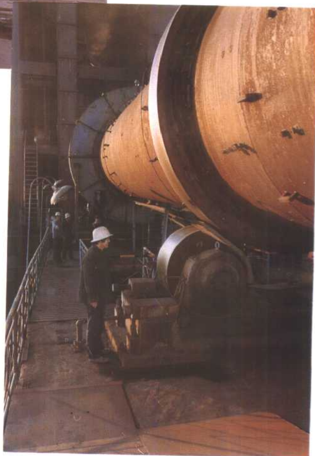
承德钢铁厂生产球团矿的 链篦机——迴转窑
