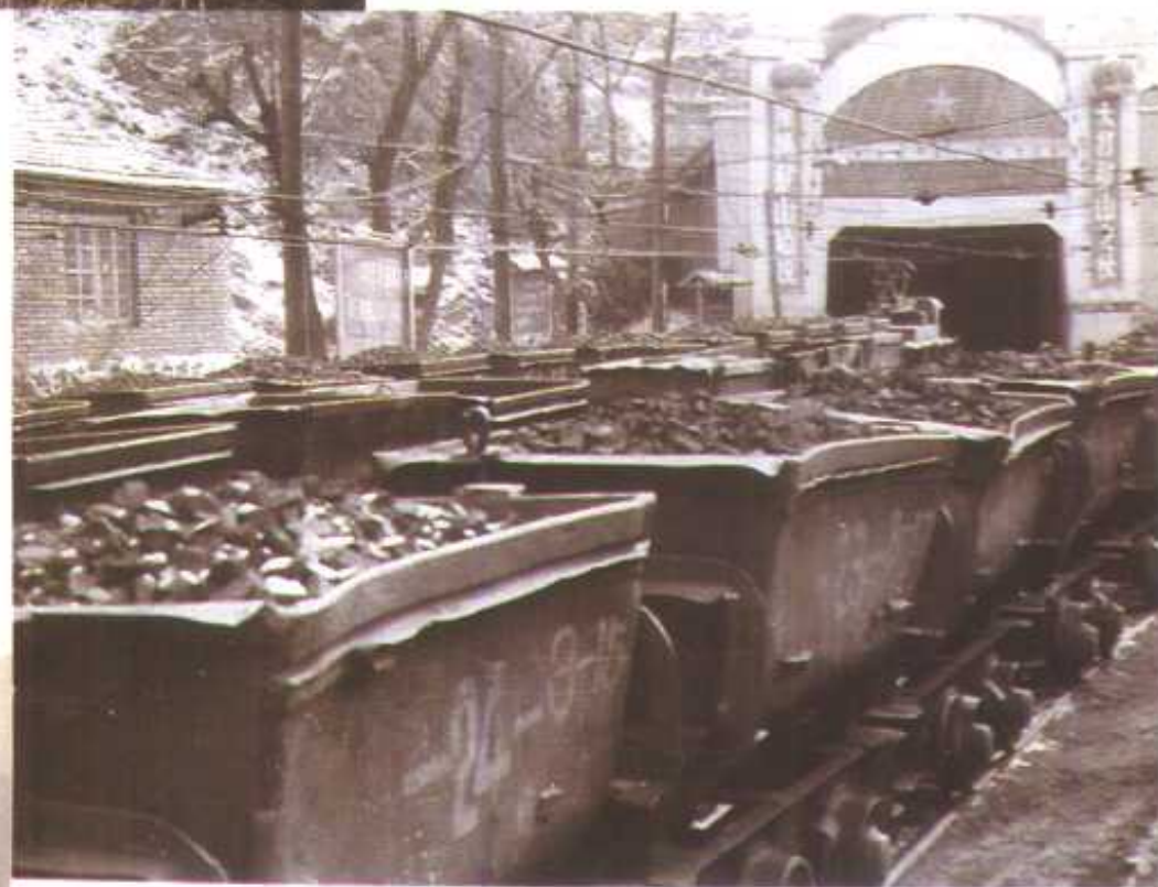
宣化钢铁公司龙烟铁矿 1080 平峒坑口
