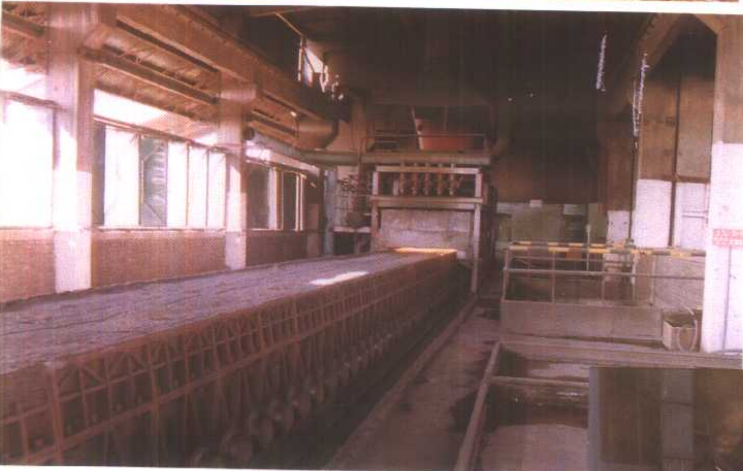
石家庄钢铁厂 24 米 2 烧结机
