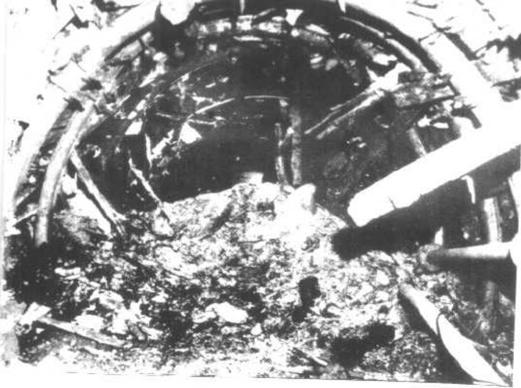
◀ 震灾使开滦唐山矿十三水平巷道局部塌顶。 ▼ 卢桂兰在瓦砾下埋压了13天零8小时，被解放军救出 后正在医院治疗。
