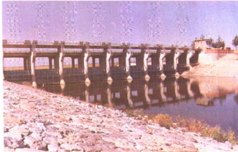
西码头蓄水闸
