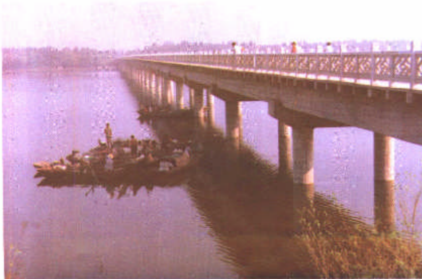
赵王新渠毕坊桥
