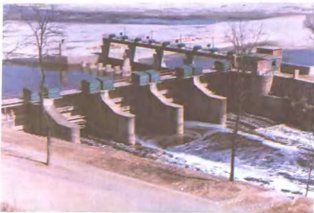
输水总干渠渠首闸
