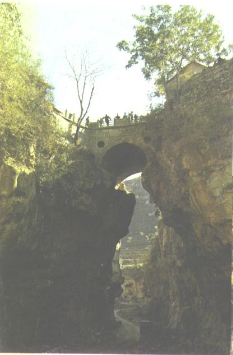
古神堂口——凉沟桥
