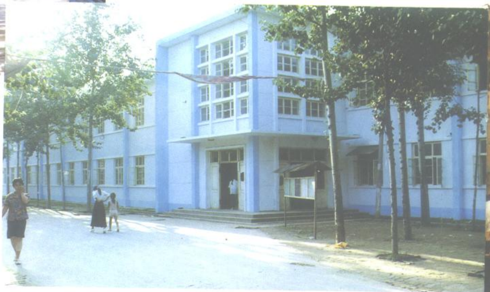
县医院门诊楼▶
