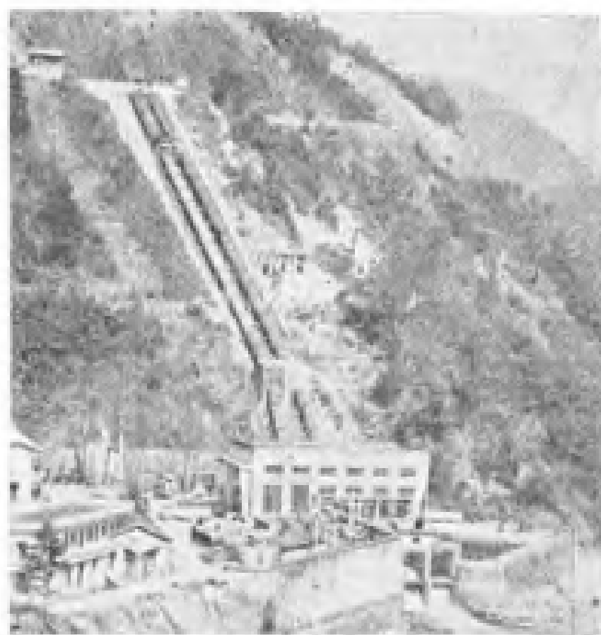
南靖船场水力发电站
