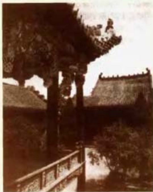
安徽亳州山陝會館花戲樓歌臺 (轉載自《中原寶藏花戲樓》)
