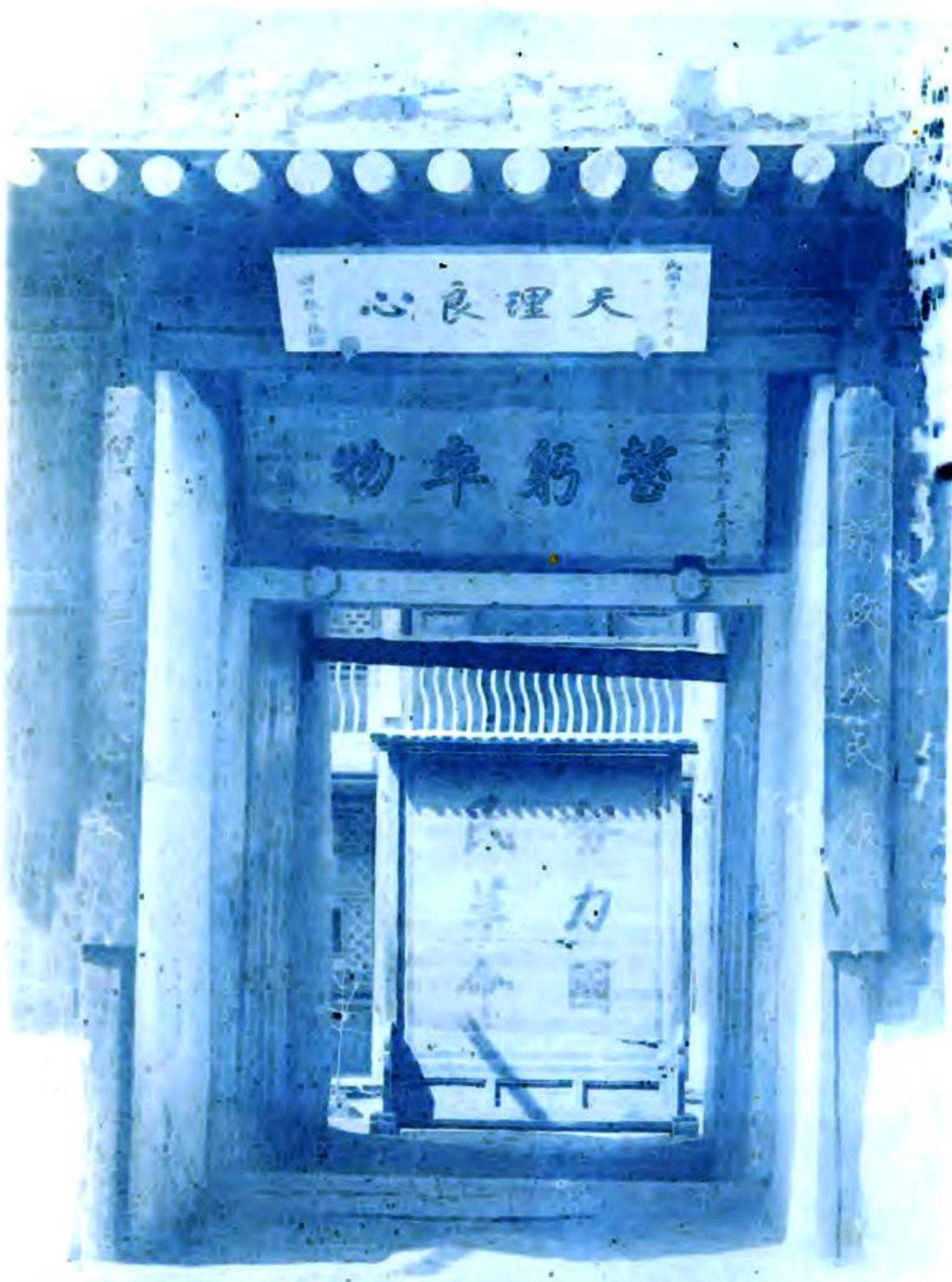
拉卜塔設治局二門
