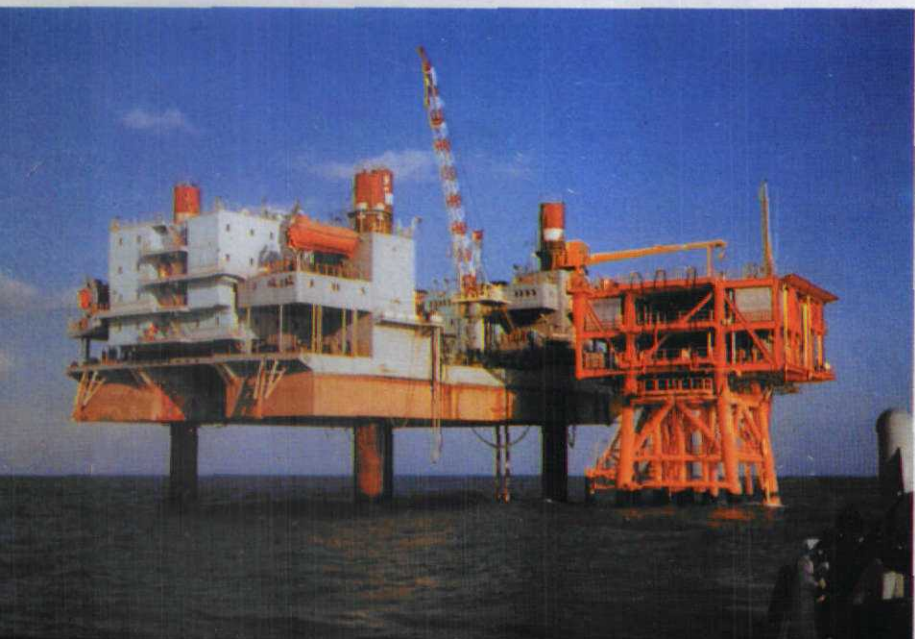
◀ BZ28-1 平台和渤 海九号平台，上部设备 由中国石油化工设备成 套公司制造
