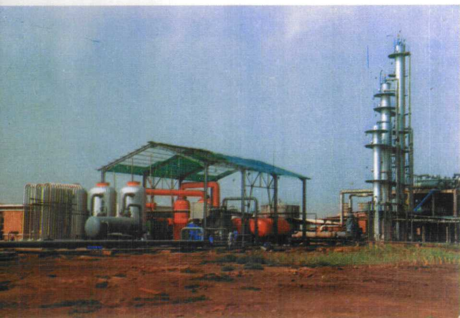
◀ 航空工业部第 六〇九研究所研制 的涡轮膨胀制冷轻 烃回收装置 (航空工业部供稿)
