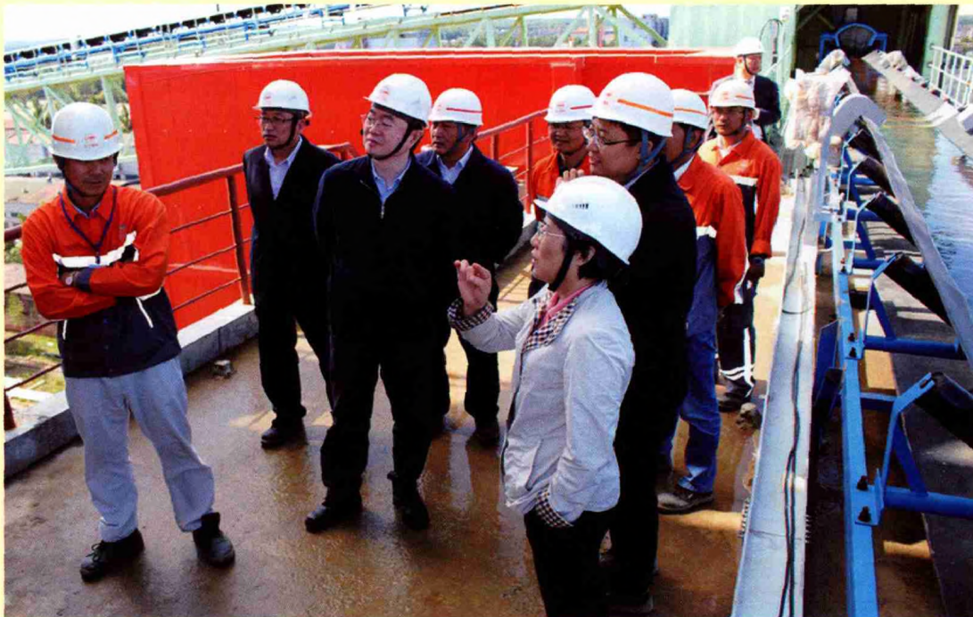
2015年7月18日，曾祥东副总经理率国机集团安全检查团在中工国际白俄罗斯40万t泥浆厂项目现场检查工作。
