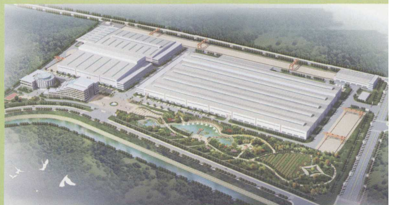
● 太原锅炉集团有限公司搬迁改造项目
