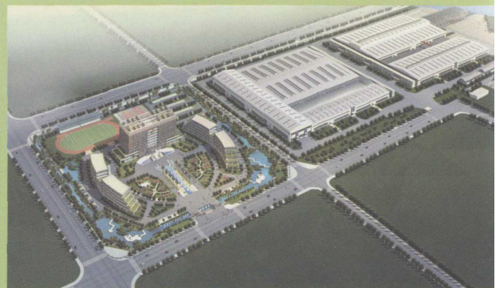
● 上海蓝滨石化设备有限公司重型石化装备及电站空冷设备研发制造项目
