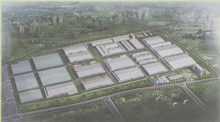
● 宝鸡石油机械有限责任公司搬迁改造项目
