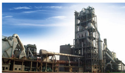
日产5 000t新型干法水泥生产线
