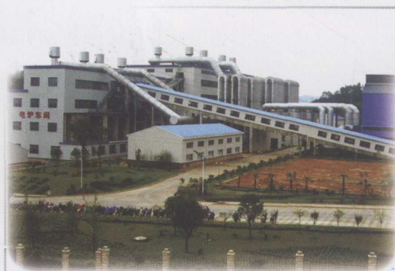
永昌矿热炉全貌
