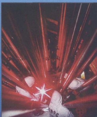
核电控制棒驱动机构正在安装
