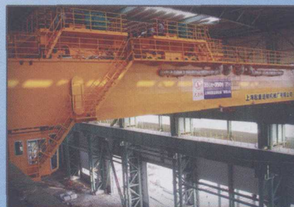
安装在临港的350t+350t起重机
