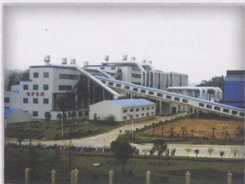
永昌矿热炉全貌
