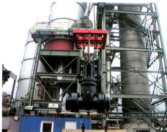
主蒸汽隔离阀
