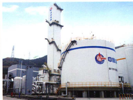
宁波LNG冷能空分装置
