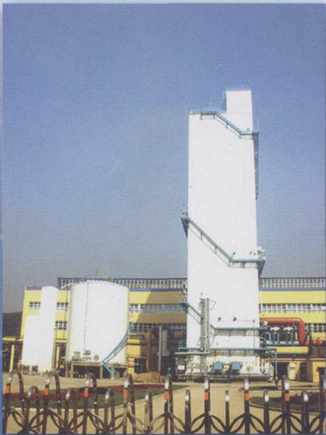
本溪北台钢铁集团公司五万空分设备
